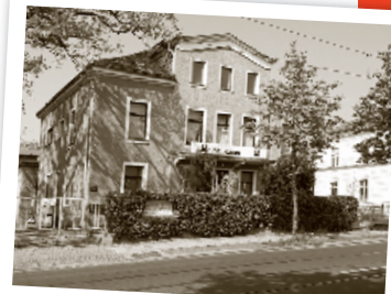
In diesem Gebäude an der Bautzener Landstraße 107 (früher Schillerstraße 17) in Dresden befand sich die Wigman-Schule. Der Übungsraum wurde 1920 in expressionistischer Manier „knallrot“ gestrichen.
